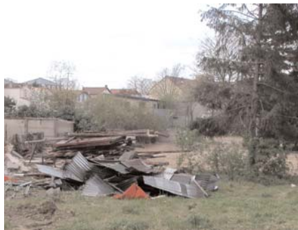
Démolition, travaux, plantations Parc urbain
