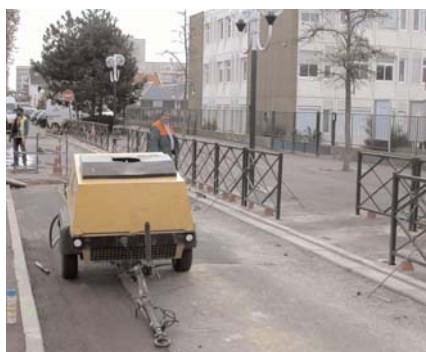
Aménagement sécurité, rue Parmentier
