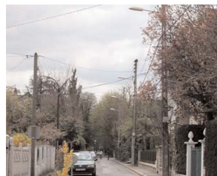
Réfection de l'éclairage public, avenue du Petit Lac
