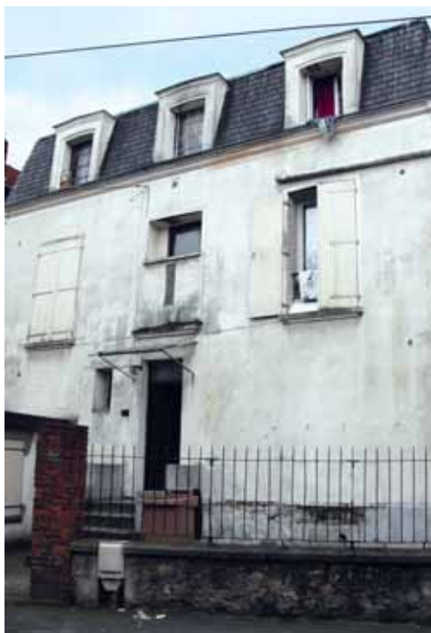
La propriété située au 14 avenue Custine sera vendue au bailleur VALESTIS pour réaliser des logements sociaux.
