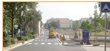
Enfouissement des réseaux rue du Général Leclerc
